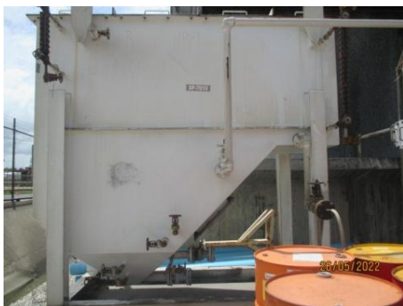
รูปที่ 5 Oil Separator
